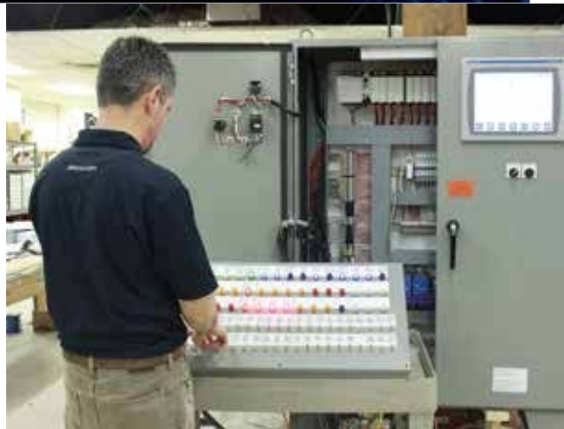
Моделирование безопасности системы управления горелкой выполняется на работающем котле с несколькими горелками
